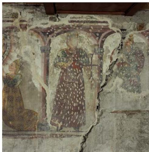
**Fig.44 –Prima stanza- La profonda frattura che attraversa la parete**
