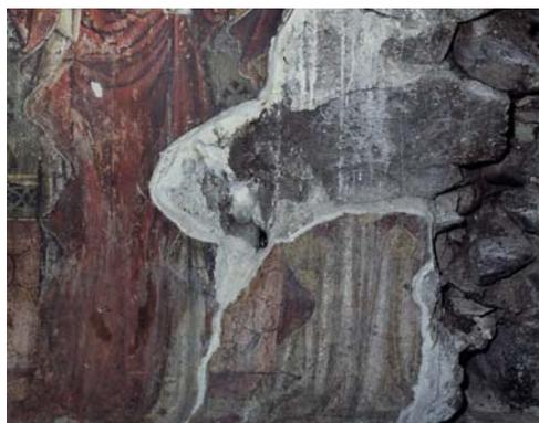
**Figura 16. -Terza stanza- Particolare con la successione stratigrafica del supporto murario: la muratura, l’arriccio e l’intonaco pittorico.**
